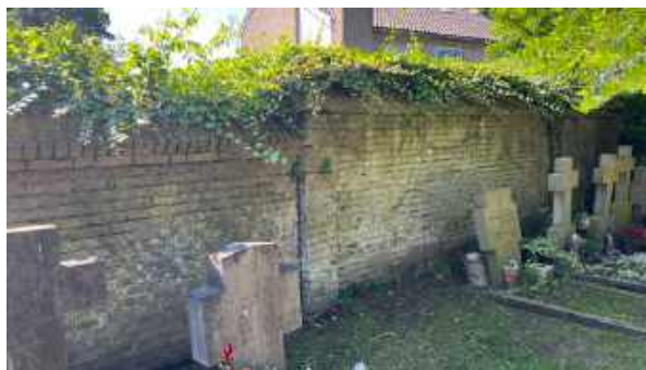
overgang van muurdelen uit verschillende bouwfasen (oostzijde)
